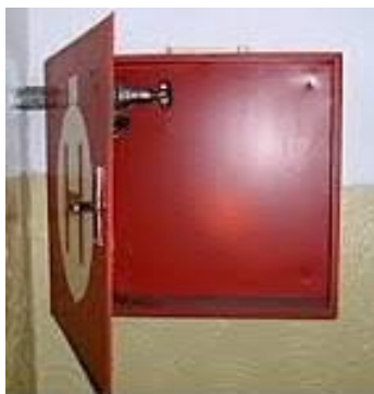
Obr.6. Hydrantová skříň bez hadice a proudnice
