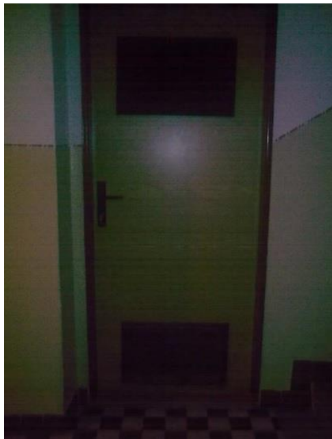
Obr.4. Dveře do kotelny přístupné z chodby
