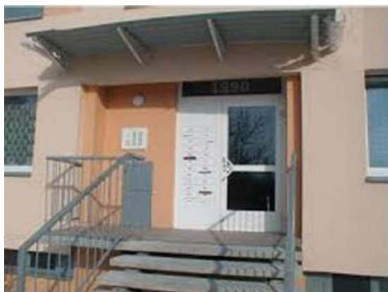
Obr.3. Přístřešek nad vstupními dveřmi zakrytý tabulemi z plechu
