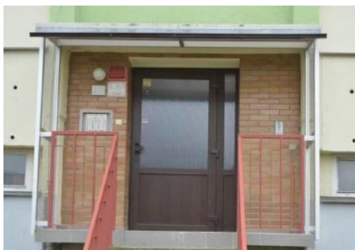
Obr.2. Vstupní část z PMMA sestávající ze stříšky a bočních stěn
