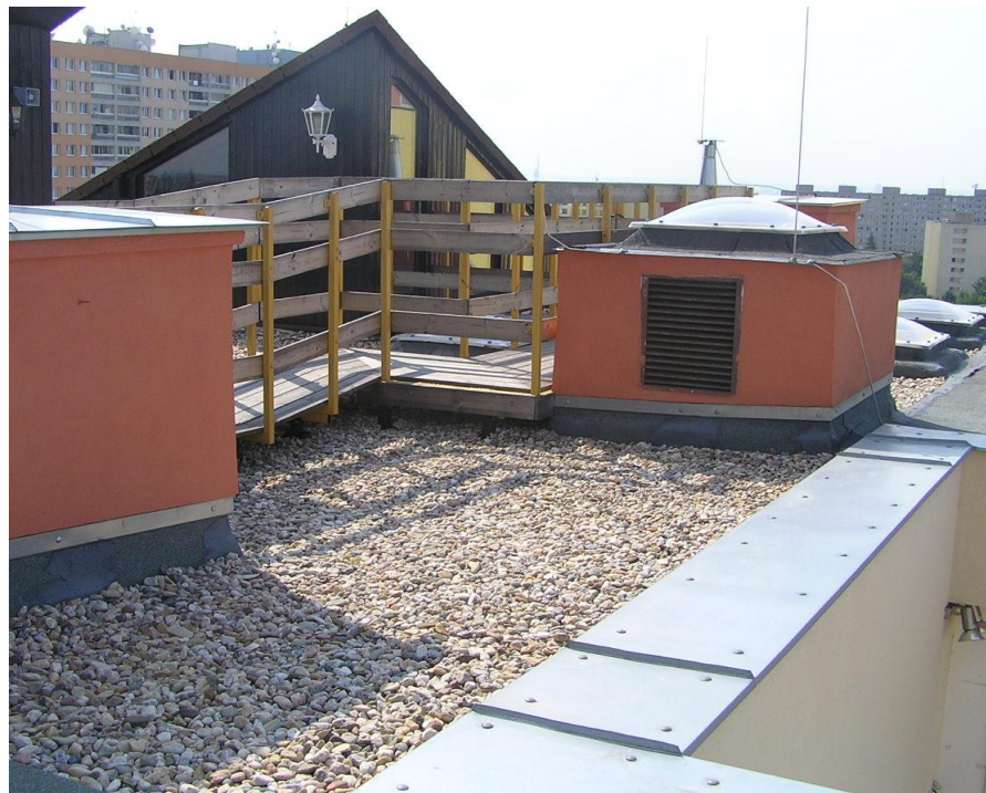
Zalomená dřevěná lávka u odvětrávacích šachet s vyústkami
