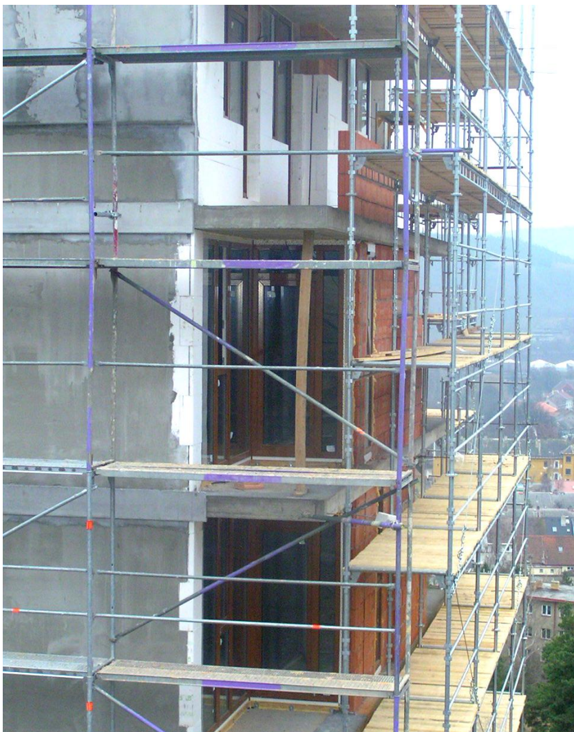
Pohled ze SZ rohu na částečně zateplený objekt
