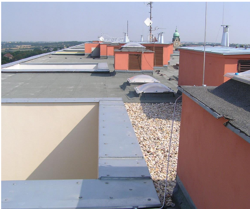
Atria se světlíky na střeše u jednotlivých podstřešních bytů
