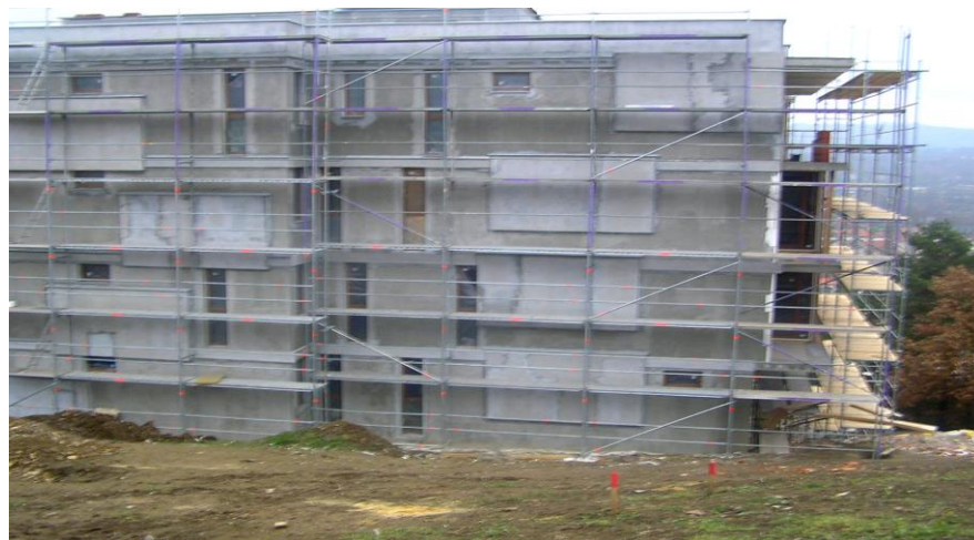
Severní zateplená fasáda
