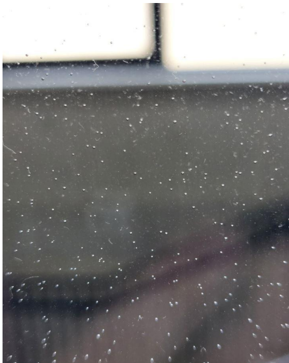
Průhledné zasklení s bublinkami v 1.PP
