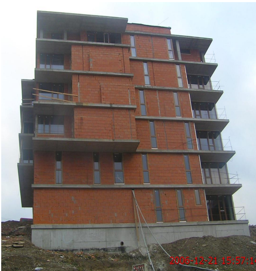
Jižní pohled na nezateplený objekt
