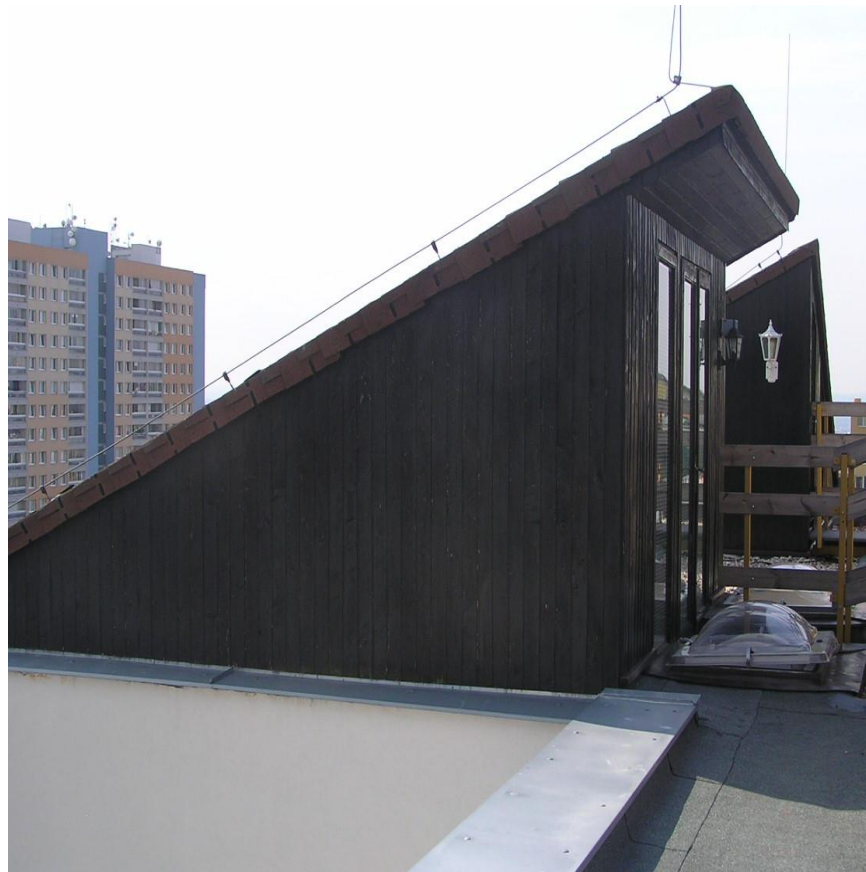
Dvě dřevěné nástavby se šikmou pultovou střechou nad úrovní ploché střechy
