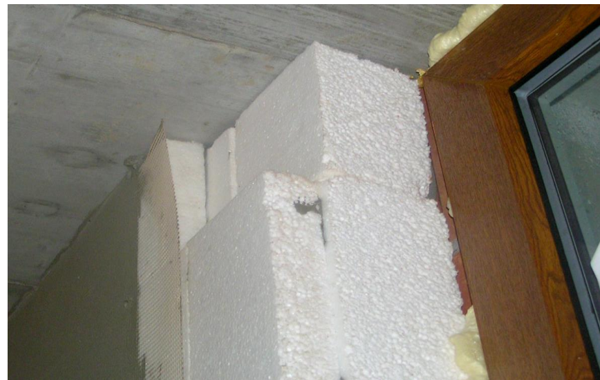
Detail zateplení EPS ve 2 vrstvách
