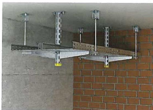
Obrázek C.3 – Vicenásobná oboustranná montáž kabelové lávky / roštu na společném závěsu s pomocným závěsem ze závitové tyče
