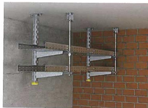
Obrázek C.2 – Vícenásobná jednostranná montáž kabelové lávky / roštu na společném závěsu s pomocným závěsem ze závitové tyče
